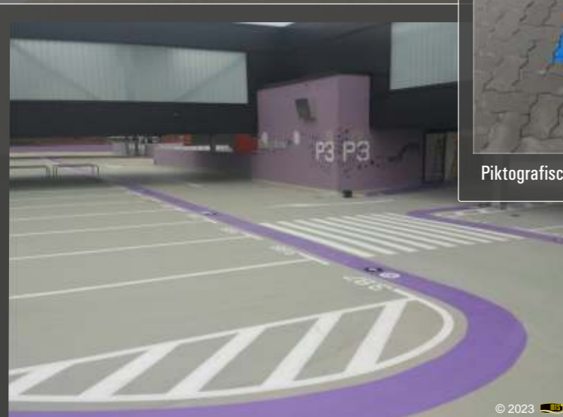
Farbliche, vollflächige Bodenbeschichtung der Fußwege für mehr Sicherheit
