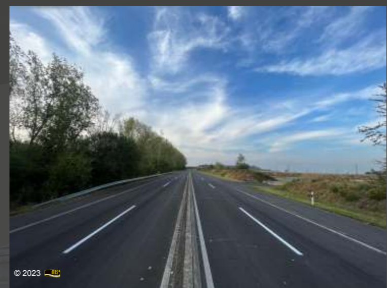
Neumarkierung der Mittellinien einer 4-spurigen Bundesstrasse
