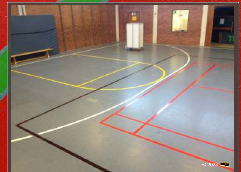
Sanierung einer Sporthalle mit geänderten Sporthallenmarkierungen
