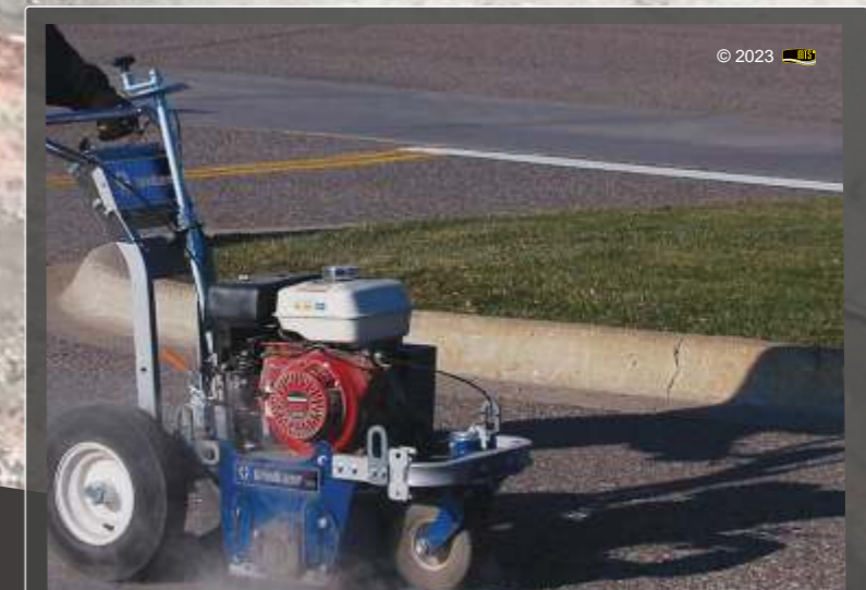
Mechanisches Feinfräsen einer nicht tragenden Dickschichtmarkierung
