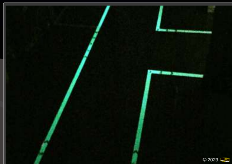
Kombination aus Fahrweg und langnacheuchtendem Flucht und Rettungsweg
