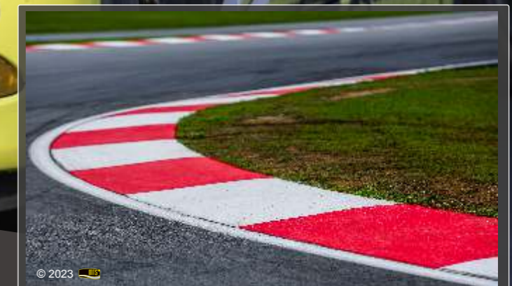
2 farbige Kerb Markierung mit eingestreutem Griffmittell
