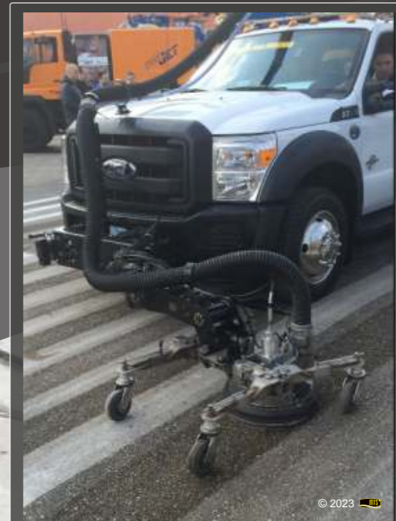
Wasserhochdruckfräsen eines Fußgängerüberwegs
