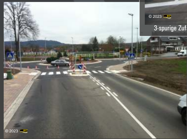
Neumarkierung eines Kreisverkehrs gem. den Vorgaben der RMS
